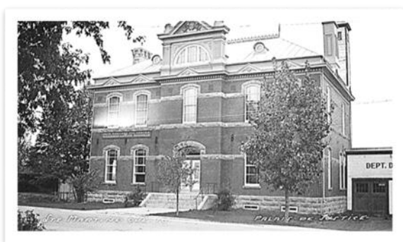
Vers 1945, cheminées et tour de séchage. De 1926 à 1966, le garage des pompiers est attenant. « Ancien palais de justice » aurait-il fallu inscrire en vignette.
